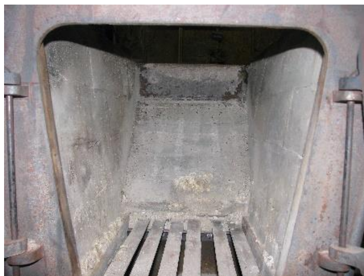
Résultat final. Du ciment à haute température est utilisé pour tenir les briques ensemble et colmater les fuites.
