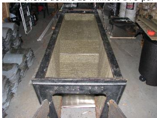
Panneaux isolants installés dans l'évaporateur
