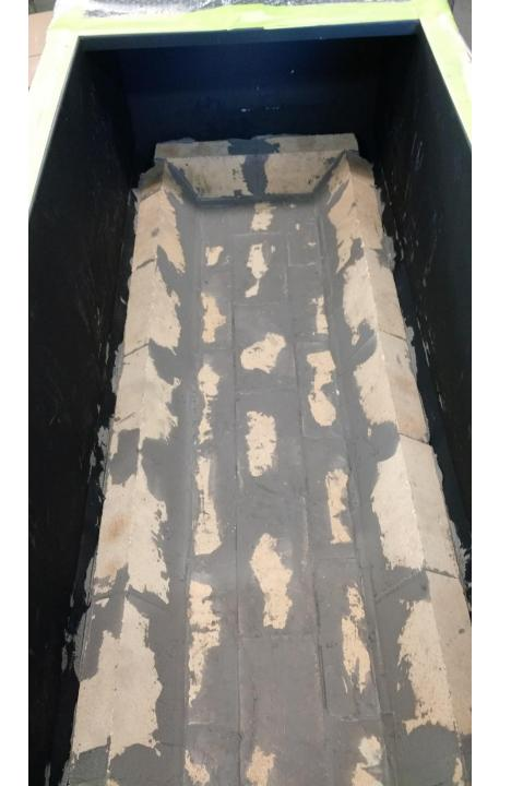
LAY THE BRICKS ON THE SIDE AND REAR WALLS.
